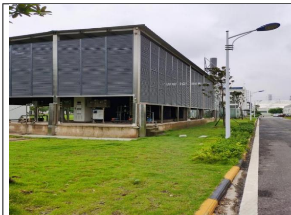
次氯酸钠储罐及周边围堰
