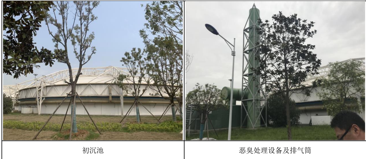
图 4.4-2 汉西污水处理厂主要处理设施实景照片
