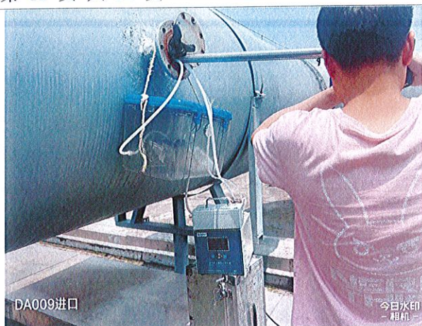
DA009 进口◎9#有组织排放废气检测点位
