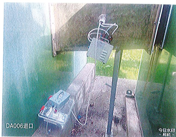
DA006 进口◎6#有组织排放废气检测点位
