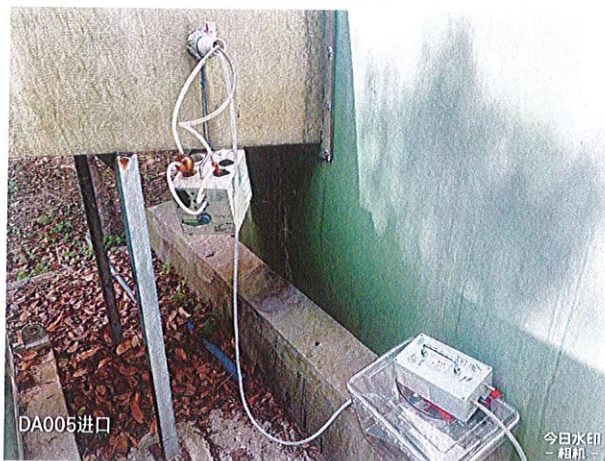
DA005 进口◎5#有组织排放废气检测点位
