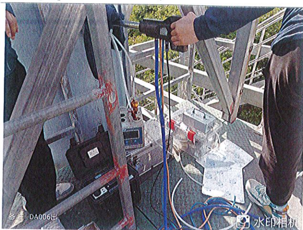
DA006 出口◎15#有组织排放废气检测点位
