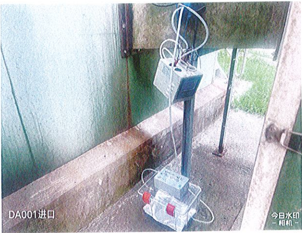
DA001 进口◎1#有组织排放废气检测点位
