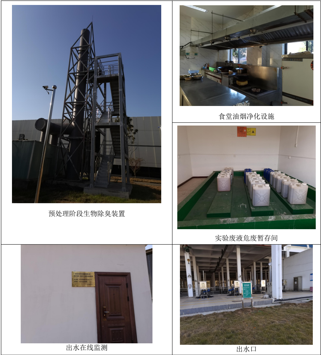
图 2.2-4 已建工程主要环保措施现状图
