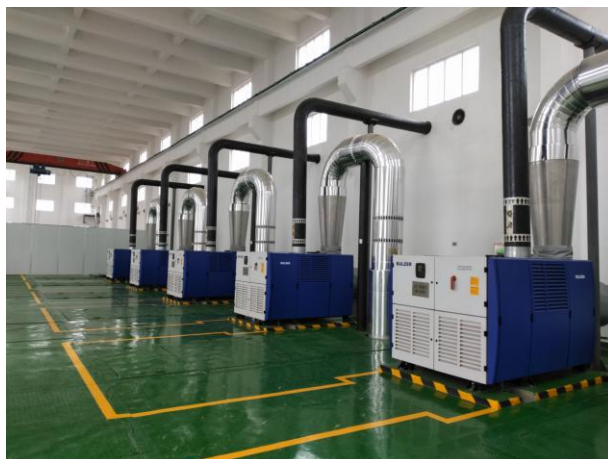
B 区鼓风机房封闭
